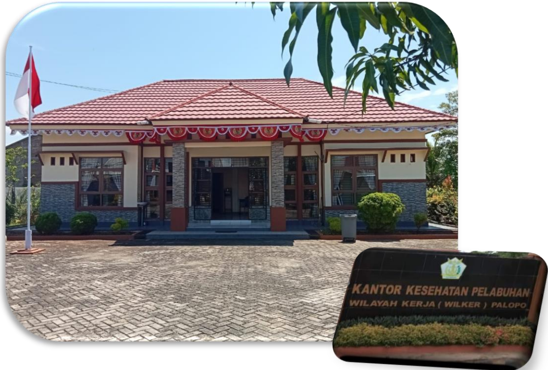
Gambar II.D.32 Gedung Kantor Wilker Pelabuhan Palopo
